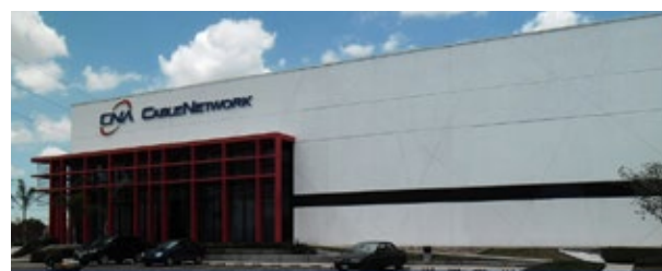
Instalaciones de CNA en San Luis Potosí
