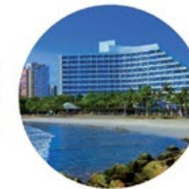
redes de datos, televisión y VOD para edificios especiales, como hoteles, hospitales y escuelas.
